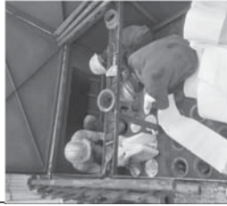
ถอดตะแกรง และถังกองเก่าออก
