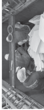
ถอดตะแกรง และถังกองเก่าออก
