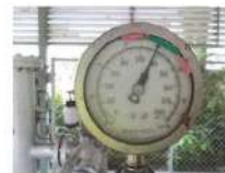
รูปความดันก่อนเข้าอุปกรณ์ปรับลดแรงดัน
