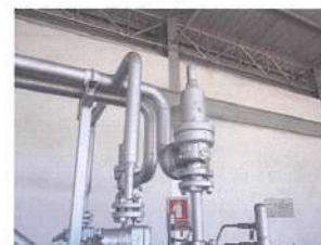
รูปอุปกรณ์ควบคุมความดันก๊าซเกินพิกัดแบบระบาย
