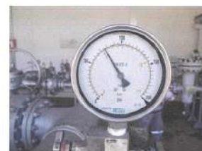
รูปมาตรวัดแรงดันหลังจากอุปกรณ์ปรับลดแรงดัน
