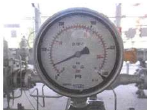
รูปมาตรวัดแรงดันก่อนเข้าอุปกรณ์ปรับลดแรงดัน
