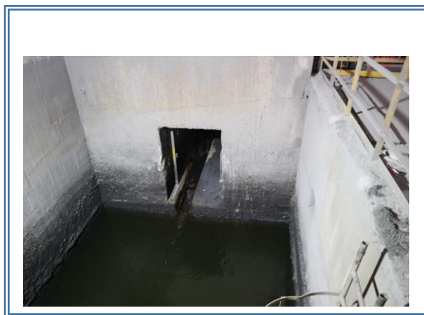
รูปที่ 3.8 บ่อดักตะกอน (Scale) ภายในโรงเหล็กแท่ง
