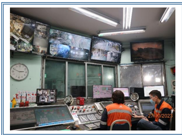
รูปที่ 3.31 ห้องควบคุมเพื่อลดเสียงที่ติดตั้งเครื่องปรับอากาศ และแสงสว่างภายในห้องควบคุม
