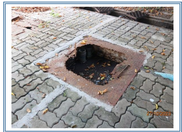
รูปที่ 3.9 บ่อเกรอะ และบ่อซึมบริเวณโรงอาหารภายในโครงการ
