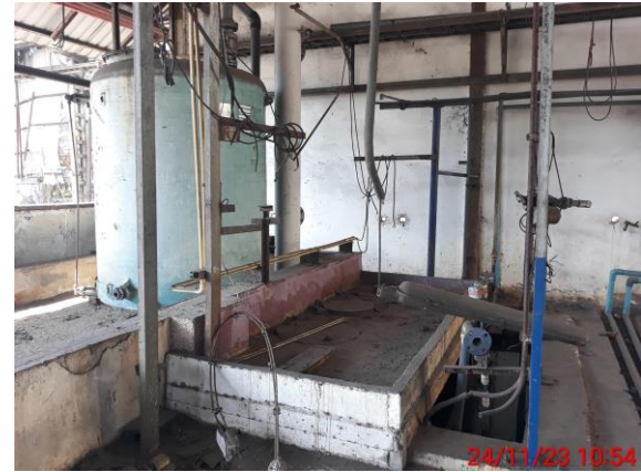
รูปที่ 12 ระบบปรับปรุงสภาพน้ำ
