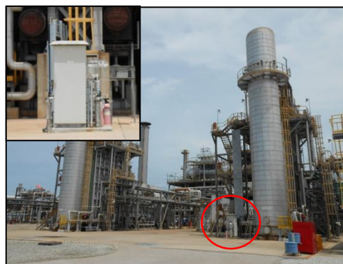
รูปที่ 3-12 CEMS ของปล่อง HRSG
