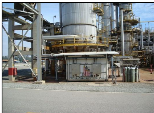
รูปที่ 3-9 CEMS ของปล่อง Tail Gas Treatment Unit
