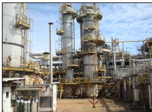
รูปที่ 3-6 Tail Gas Treatment Unit
