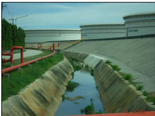
รูปที่ 3-27 รางระบายน้ำฝนแบบเปิด
