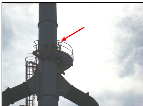
รูปที่ 3-7 Oxygen Analyzer
