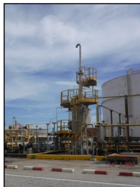
รูปที่ 3-14 Scrubber ที่ Sulfur Tank
