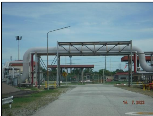
รูปที่ 3-49 Pipe Rack สำหรับท่อขนส่งน้ำมัน
