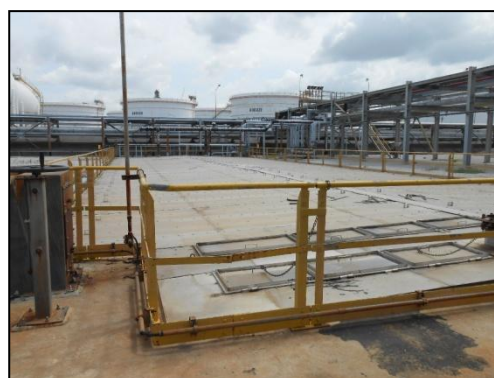
รูปที่ 3-18 ฝาปิดที่ API Oil/Water Separator
