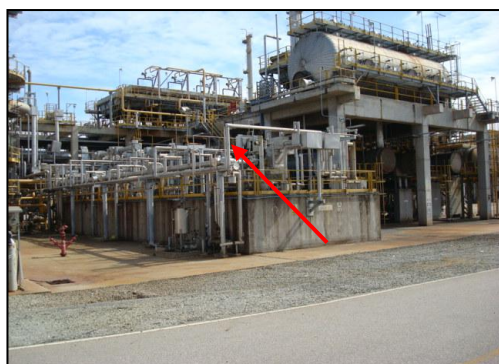
รูปที่ 3-10 ระบบดูดอากาศจากบ่อซัลเฟอร์
