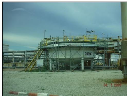
หน่วยแยกน้ำมันออกจากน้ำเสีย (API Separator Unit)
