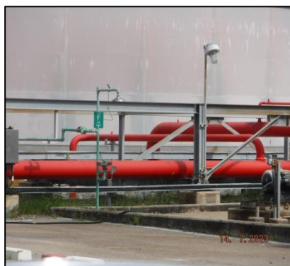
รูปที่ 3-35 ฝักบัวและอ่างล้างตาฉุกเฉิน
