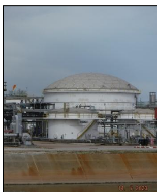
รูปที่ 3-17 ฝาครอบถัง Equalization เพื่อลดกลิ่น
