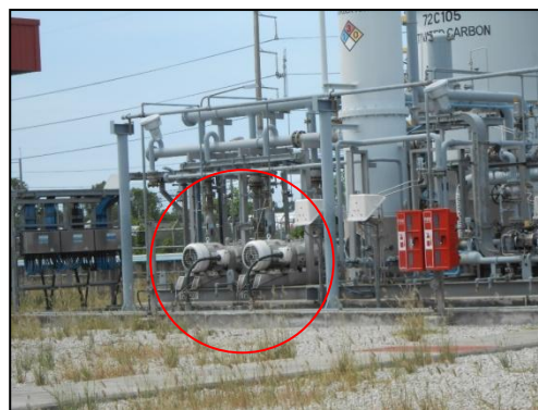
รูปที่ 3-21 Pump/Blower ของ VRU
