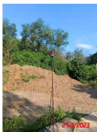
รูปที่ 24 การติดตั้งสัญญาณเตือนก่อนทำการระเบิด
