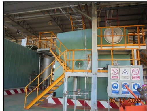
รูปที่ 2-4 หม้อน้ำ (Boiler)
