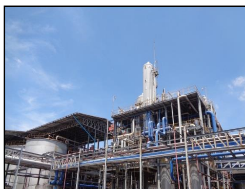
รูปที่ 2-15 ถังหมัก หอกลั่น และหอกำจัดน้ำที่เป็นระบบปิด
