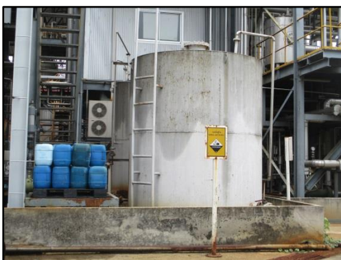
รูปที่ 2-52 ถังเก็บ H_2SO_4
