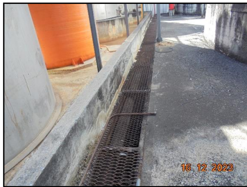
รูปที่ 2-24 รางระบายน้ำเสียภายในพื้นที่โครงการ
