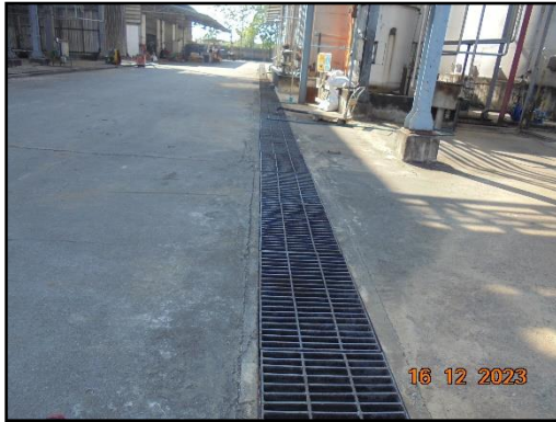
รูปที่ 2-23 รางระบายน้ำรอบพื้นที่โครงการ
