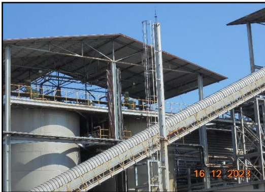
รูปที่ 2-3 ปล่องระบายของหม้อน้ำ ขนาด 2 ตัน
