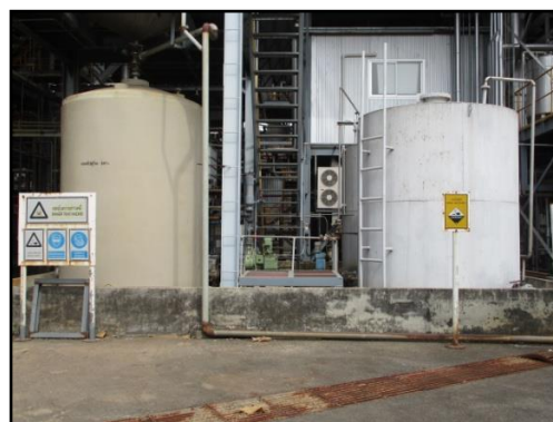
รูปที่ 2-52 ถังเก็บ H_2SO_4
