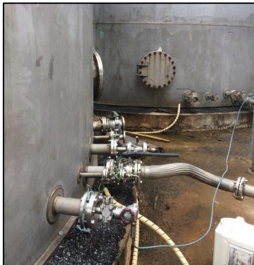
รูปที่ 2-44 การติดตั้ง High level transmitter และ level meter บริเวณถังเก็บเอทานอล
