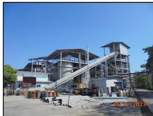
รูปที่ 2-3 ปล่องระบายของหม้อน้ำ ขนาด 2 ตัน
