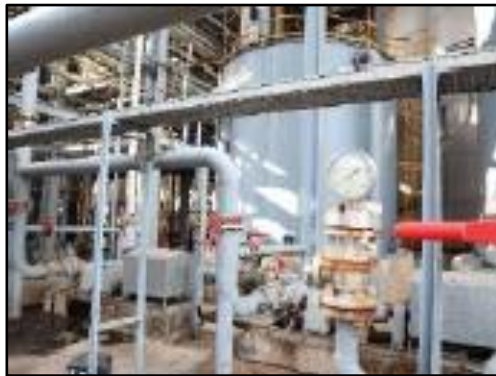
รูปที่ 2-46 มาตรวัด (Flow meter) เพื่อตรวจสอบการไหลของกากน้ำตาล
