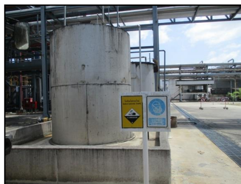
รูปที่ 2-51 ถังเก็บ NaOH
