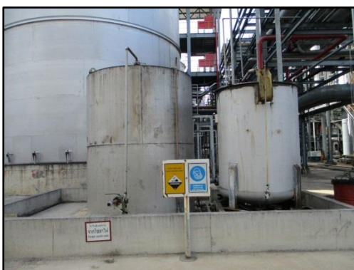
รูปที่ 2-51 ถังเก็บ NaOH
