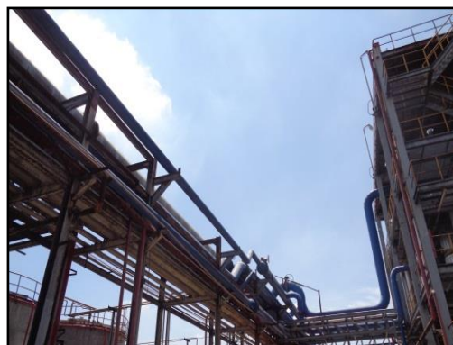
รูปที่ 2-14 ระบบขนส่งกากน้ำตาล เข้าสู่พื้นที่โครงการเพื่อใช้ในกระบวนการผลิตเป็นระบบท่อ
