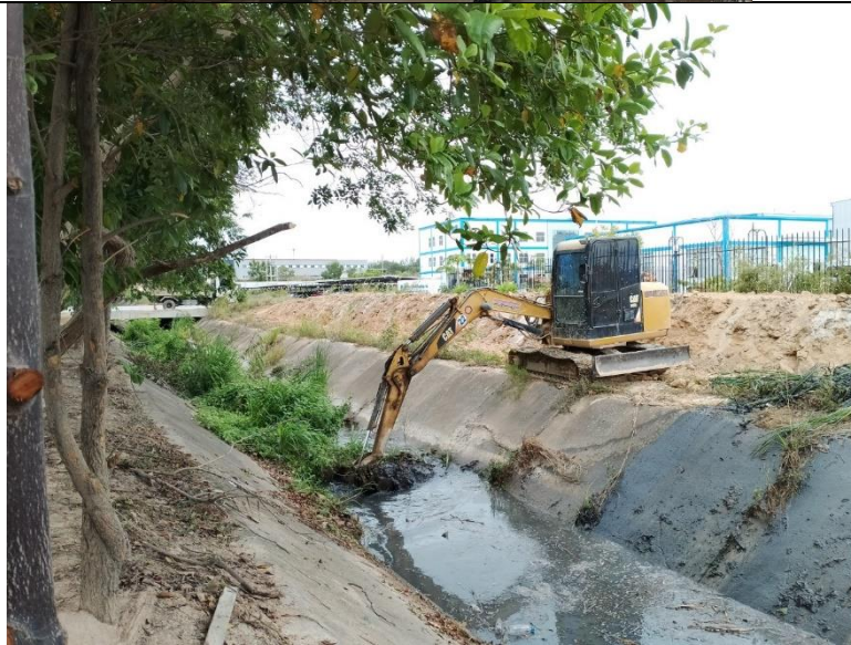
ภาพระหว่างดำเนินการขุดลอกตะกอนในรางระบายน้ำฝน
