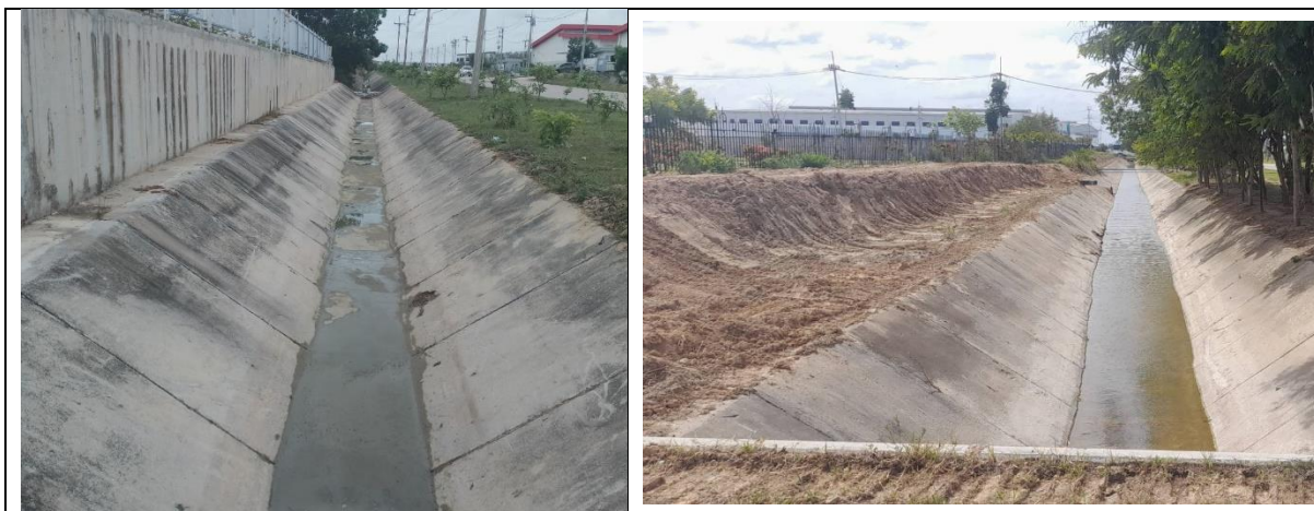
ภาพหลังดำเนินการขุดลอกตะกอนในรางระบายน้ำฝน
