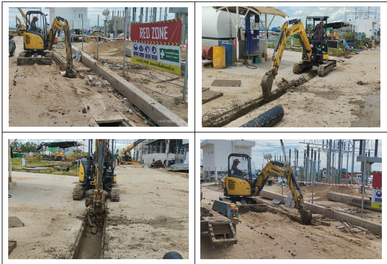
รูปที่ 2-14.4 การขุดลอกรางระบายน้ำ
