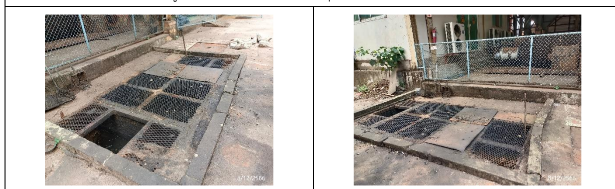
รูปที่ 23 บ่อแยกน้ำและน้ำมัน บริเวณอาคารยานยนต์ของโครงการ
