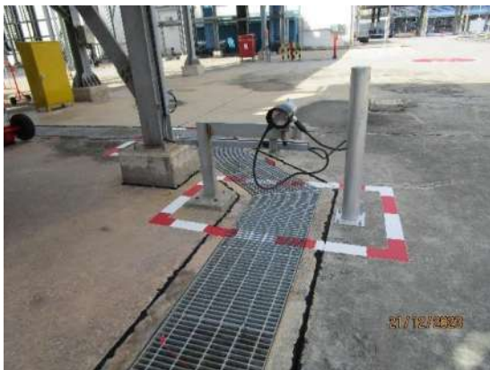
รูปที่ 2-25 ระบบตรวจวัดการรั่วไหลของแก๊ส (Gas Detector)
