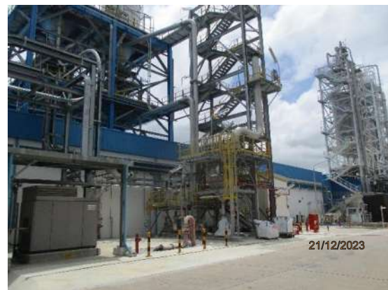
รูปที่ 2-32 ระบบรวบรวมฝุ่นจากบริเวณที่มีการฟุ้งกระจาย ของสารเติมแต่งในอาคาร Pellet 3
