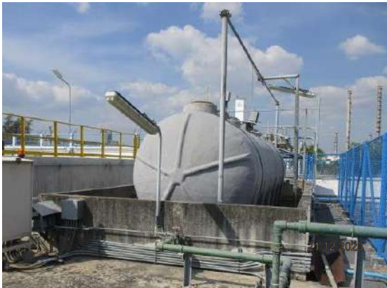
รูปที่ 2-3 ถังบำบัดน้ำเสียสำเร็จรูป (SATs)
