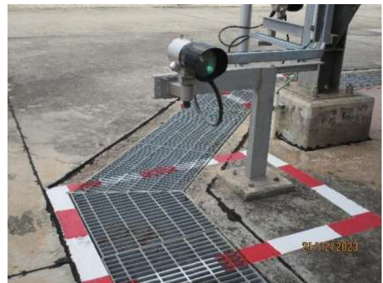
รูปที่ 2-25 ระบบตรวจวัดการรั่วไหลของแก๊ส (Gas Detector)
