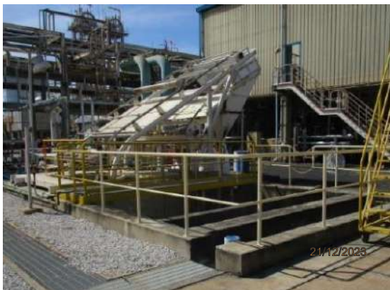
รูปที่ 2-7 บ่อตกโพลีเมอร์และเครื่องตกตะกอน
