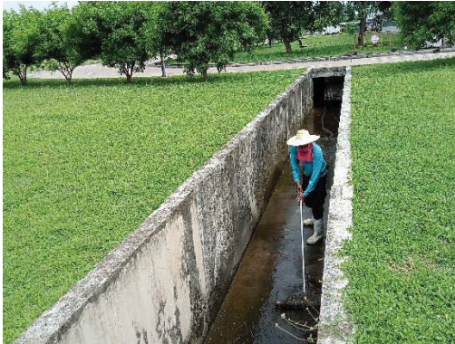
ภาพที่ 2-34 การล้างทำความสะอาดท่อระบายน้ำ
