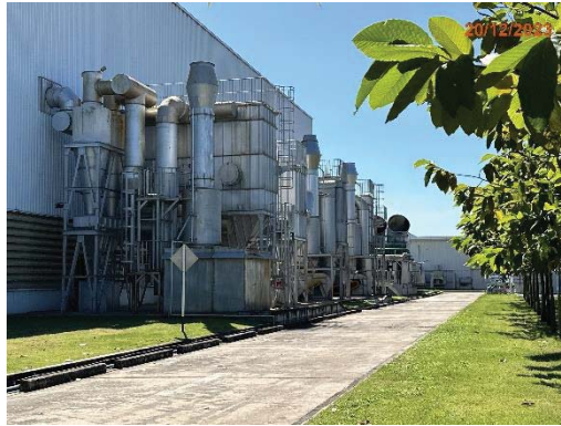
ภาพที่ 2-1 การติดตั้งอุปกรณ์บำบัดมลพิษทางอากาศ
