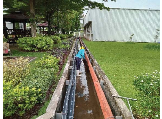
ภาพที่ 2-34 การล้างทำความสะอาดท่อระบายน้ำ
