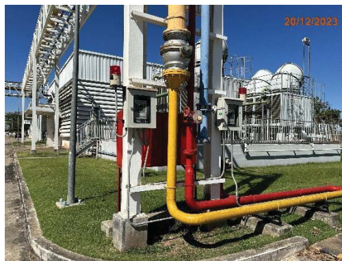
ภาพที่ 2-29 การติดตั้งระบบตรวจจัดการรั่วไหลของก๊าซ
