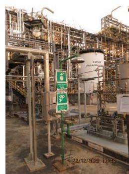
ภาพที่ 2.2-2 (60) อ่างล้างตา และฝักบัว
