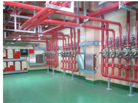
ภาพที่ 2.2-2 (48) ระบบดับเพลิงด้วยก๊าซ บริเวณที่เกี่ยวข้องกับอุปกรณ์ทางระบบไฟฟ้า สายไฟ และสถานีไฟฟ้าย่อย
