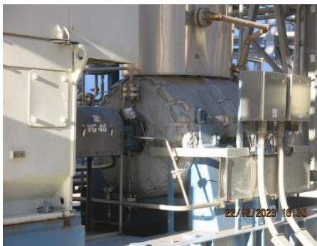
ภาพที่ 2.2-2 (34) การติดตั้งฉนวน เพื่อลดเสียงจากอุปกรณ์
