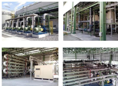
ภาพที่ 2.2-2 (19) ระบบบำบัดน้ำเสียส่วนกลาง แห่งที่ 3 ชนิด Membrane Bio-Reactor
