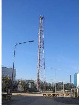
ภาพที่ 2.2-2 (12) หอเผาที่จ้งระดับเหนือพื้นดิน (Elevated Flare)
