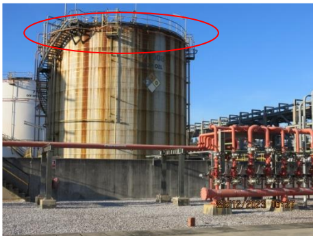
ภาพที่ 2.2-2 (47) ระบบฉีดโฟมดับเพลิง บริเวณถังเก็บ Flammable Liquid และ Combustible Liquid
