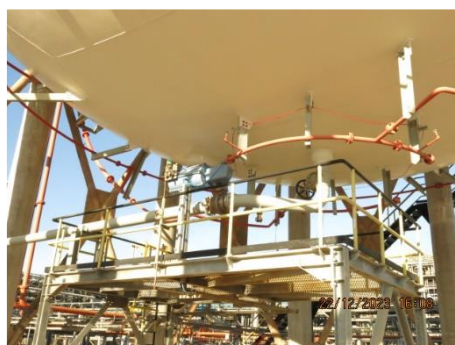
ภาพที่ 2.2-2 (67) Emergency Isolation Valve
