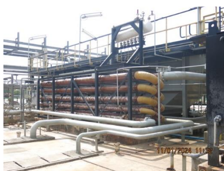
ภาพที่ 2.2-2 (23) ระบบบำบัดเบื้องต้นแบบแยกน้ำ และน้ำมันด้วยตัวกลางแบบแผ่นขนาน (CPI) และระบบบำบัดเบื้องต้นแบบใช้อากาศแยกน้ำ ออกจากน้ำมัน (IAF)
