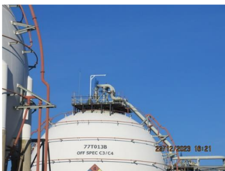
ภาพที่ 2.2-2 (71) Pressure Relief Valve ถังที่เก็บชนิดทรงกลม
