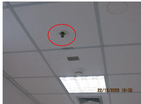
ภาพที่ 2.2-2 (54) อุปกรณ์ตรวจจับความร้อน
