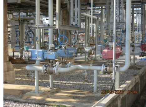
ภาพที่ 2.2-2 (79) วาล์วตัดแยกระบบ บริเวณท่อขนส่ง
