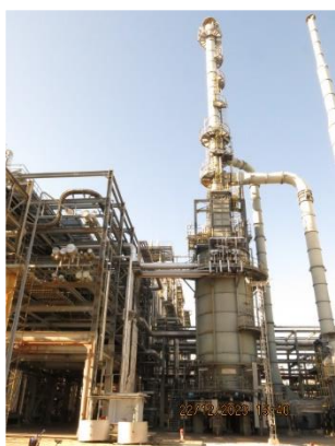
ภาพที่ 2.2-2 (1) ปล่อง Reactor Feed Preheater Stack (52B001)
