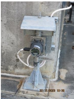
ภาพที่ 2.2-2 (55) อุปกรณ์ตรวจจับการรั่วไหลของก๊าซ
