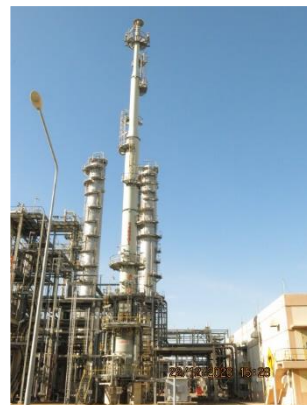
ภาพที่ 2.2-2 (6) ปล่อง Hydrodesulfurization Reactor Heater Stack (52B101)
