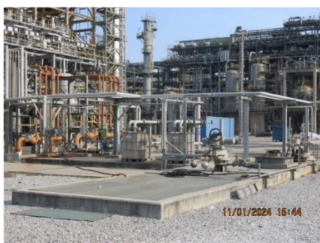
ภาพที่ 2.2-2 (22) บ่อน้ำรวบรวมน้ำปนเปื้อนน้ำมัน (Common Oily Water Basin)
