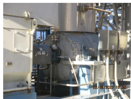
ภาพที่ 2.2-2 (66) ระบบ Shaft Sealing System สำหรับอุปกรณ์ที่มีการหมุน
