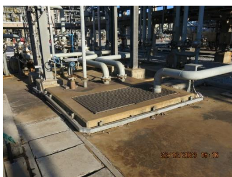
ภาพที่ 2.2-2 (20) บ่อรวบรวม (Blowdown Sump)
