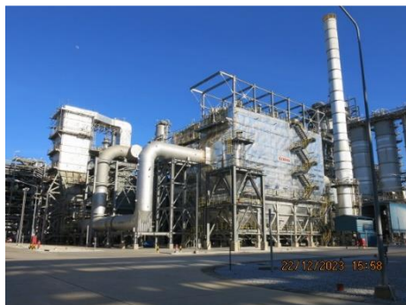
ภาพที่ 2.2-2 (9) Electrostatic Precipitator (ESP) บริเวณปล่อง (53A001)
