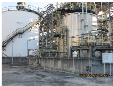
ภาพที่ 2.2-2 (65) กำแพงกันโดยรอบ บริเวณที่เก็บสารเคมี
