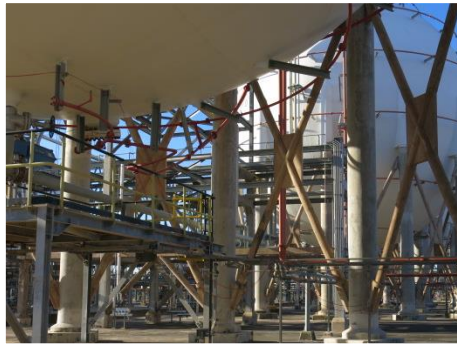
ภาพที่ 2.2-2 (45) ระบบสเปรย์น้ำดับเพลิง บริเวณถังเก็บก๊าซปิโตรเลียมเหลว LPG
