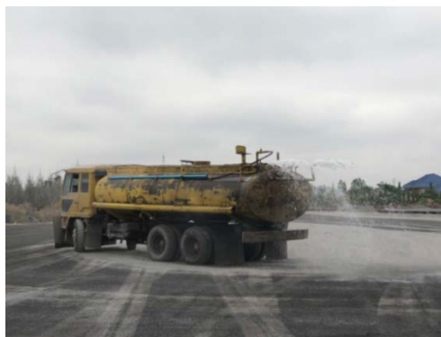
รูปที่ 2.1-20 การฉีดพรมน้ำบนเส้นทางขนส่ง
