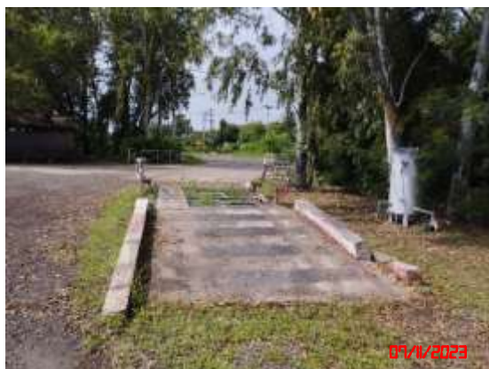
รูปที่ 11 จุดล้างล้อรถบรรทุกของโครงการ
