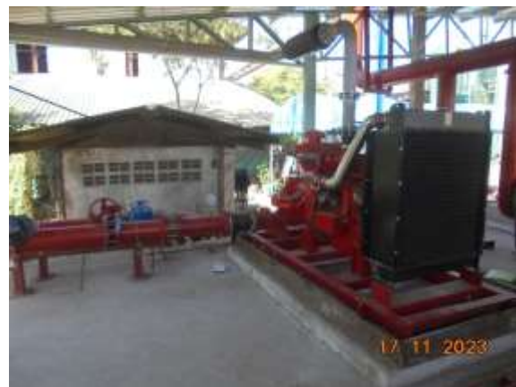
ปั้มน้ำดับเพลิงเครื่องยนต์ดีเซล
