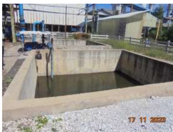
รูปที่ 15 บ่อพักน้ำทิ้งคอนกรีตรองรับน้ำทิ้ง จากหม้อไอน้ำ
