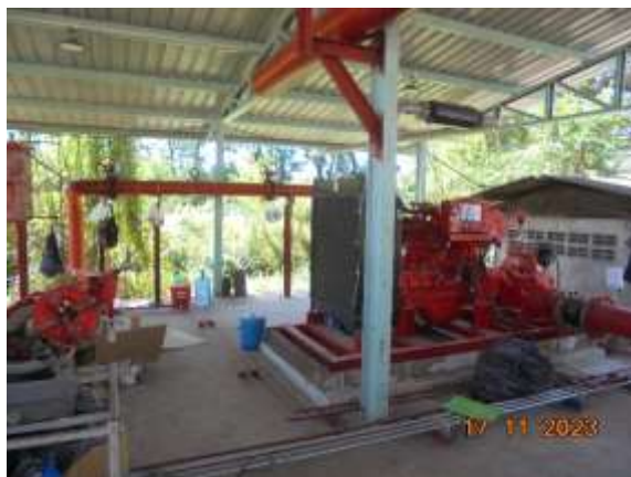
ปั้มน้ำดับเพลิงเครื่องยนต์ดีเซล
