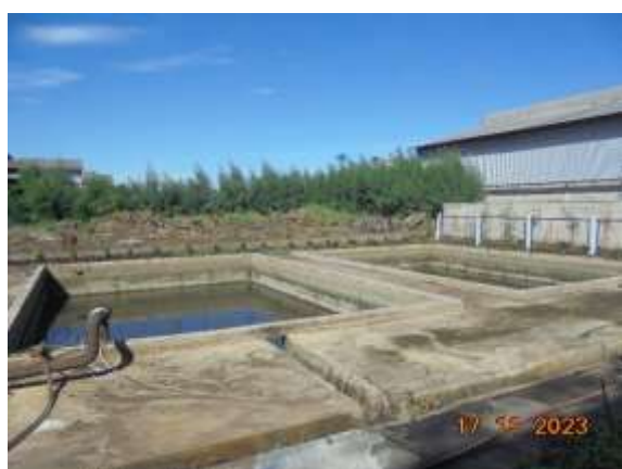
รูปที่ 14 บ่อพักน้ำทิ้งคอนกรีตรองรับน้ำทิ้ง จากระบบหล่อเย็น
