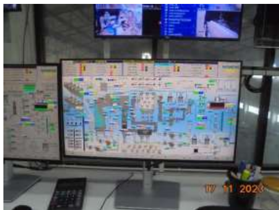
ระบบควบคุมของหม้อไอน้ำ
