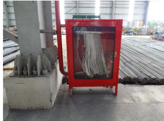
ภาพที่ 3.38 สายฉีดน้ำดับเพลิงและถังดับเพลิงชนิดผงเคมีแห้ง
