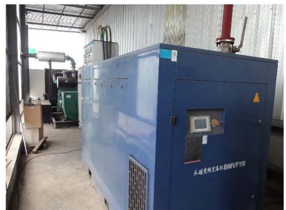
ภาพที่ 3.4 เครื่องไฟฟ้าสำรองของ ระบบดูดอากาศ
