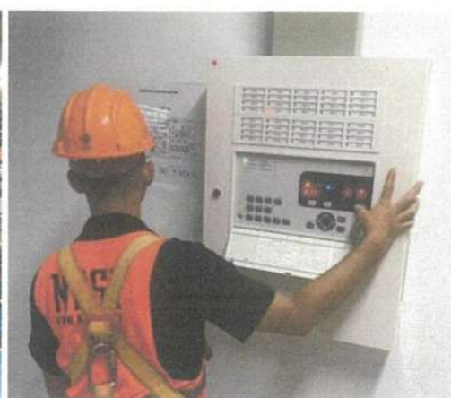
ภาพที่ 14: Control Board Testing
