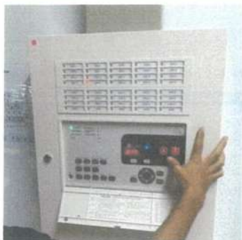
ภาพที่ 3: การทดสอบ Fire Alarm Control Panel (Board Testine)
