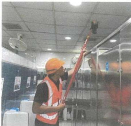
ภาพที่ 9: Smoke Detector Testing
