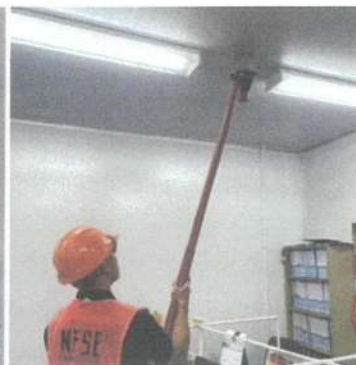
ภาพที่ 6: Automatic detector Testing
