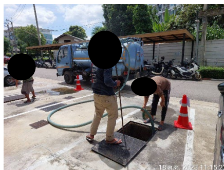
ภาพที่ 2.2-12 (ต่อ) การสูบลากตะกอน ตักตะกอน ไขมัน
