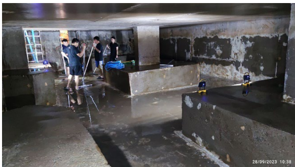
ภาพที่ 2.2-14 การดูแลรักษาถังเก็บน้ำ และการทำความสะอาด
