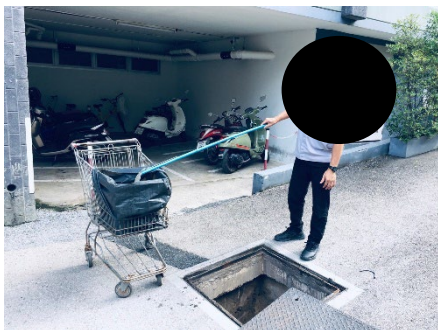
ภาพที่ 2.2-12 การสูบน้ำจากตะกอน ตักตะกอน ไขมัน
