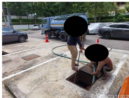
ภาพที่ 2.2-12 การสูบน้ำจากตะกอน ตักตะกอน ไขมัน
