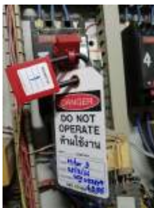
รูปที่ 2-55 ใส่กุญแจวาล์ว สวิตช์และติดป้ายแจ้ง (Lock out-Tag out)
