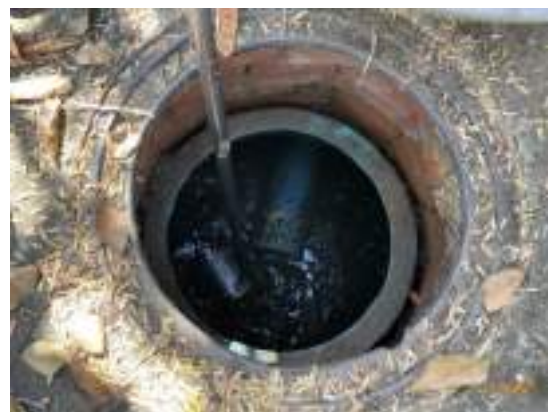
รูปที่ 2-32 ระบบบำบัดน้ำเสียแบบถังเกราะกรองไร้อากาศ
