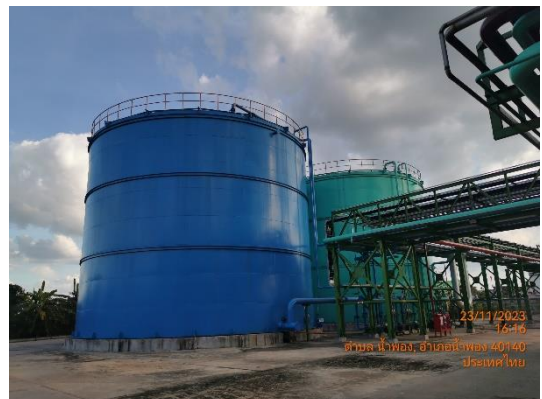
รูปที่ 5 ถังเก็บน้ำสะอาด ขนาดความจุ 2,000 ลูกบาศก์เมตร
