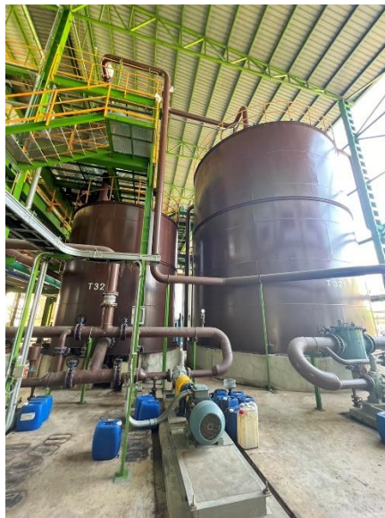
รูปที่ 3 ถังเก็บโมลาส (Molasses Buffer Tank) ขนาดความจุ 450 ลูกบาศก์เมตร
