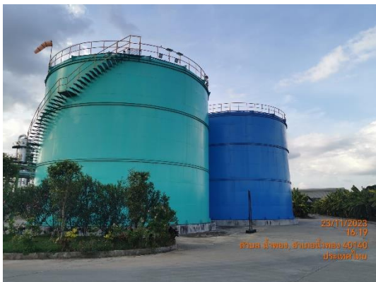
รูปที่ 5 ถังเก็บน้ำสะอาด ขนาดความจุ 2,000 ลูกบาศก์เมตร
