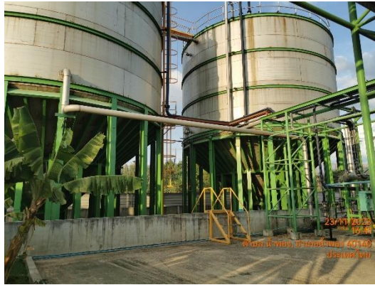
รูปที่ 7 ถังเก็บน้ำทิ้ง (Water Buffer Tank) จากระบบหล่อเย็นเครื่องจักร
