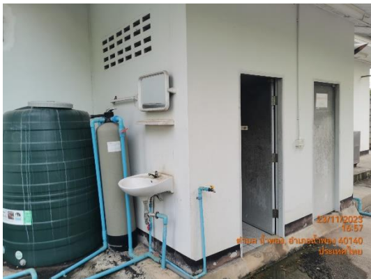
รูปที่ 8 ระบบบำบัดน้ำเสียจากอาคารสำนักงานในส่วนผลิตก๊าซชีวภาพ
