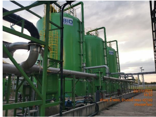
รูปที่ 13 ระบบ Bio Scrubber
