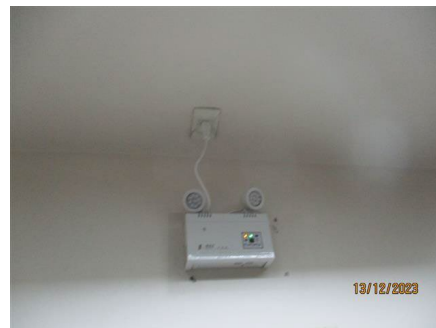
ภาพที่ 2.2-25 ไฟส่องสว่างฉุกเฉิน
