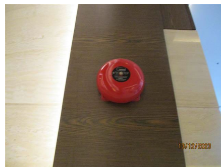
อุปกรณ์ส่งสัญญาณเตือนเพลิงไหม้
