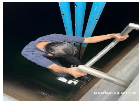
รูปที่ 3-52 ล้างถังเก็บน้ำใช้
