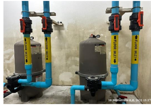
รูปที่ 3-58 ระบบกรองน้ำสระว่ายน้ำ
