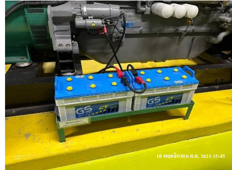
รูปที่ 3-66 แบตเตอรี่สำรอง
