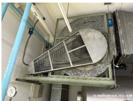
รูปที่ 3-71 พัดลมระบายอากาศ
