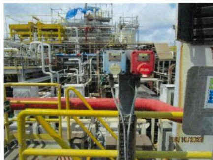
แท่นผลิต ภาพถ่ายที่ 2.2-26 Emergency Shutdown Push Button
