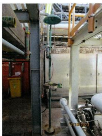
แท่นผลิต ภาพถ่ายที่ 2.2-22 อ่างล้างตาและฝักบัวฉุกเฉิน
