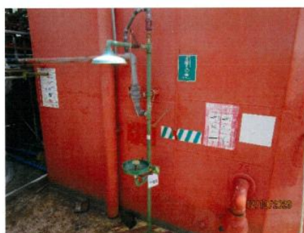
แท่นผลิต ภาพถ่ายที่ 2.2-22 อ่างล้างตาและฝักบัวฉุกเฉิน
