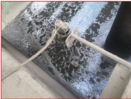
ภาพที่ 2.2-27 การติดตั้ง Level switch
