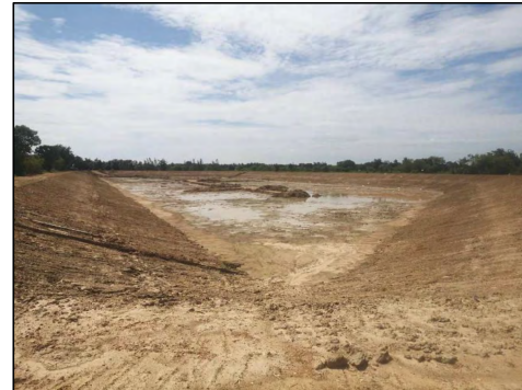
การขุดลอกตะกอนจากระบบบำบัดน้ำเสีย บ่อ D2
