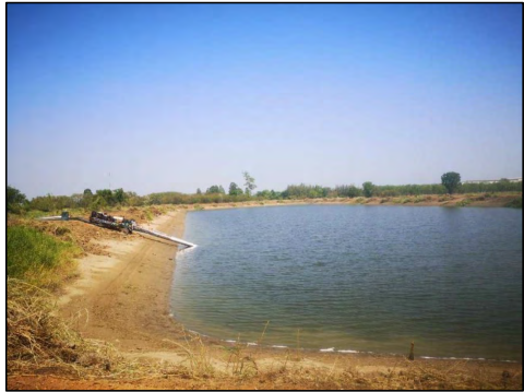
การขุดลอกตะกอนจากระบบบำบัดน้ำเสีย บ่อ D2
