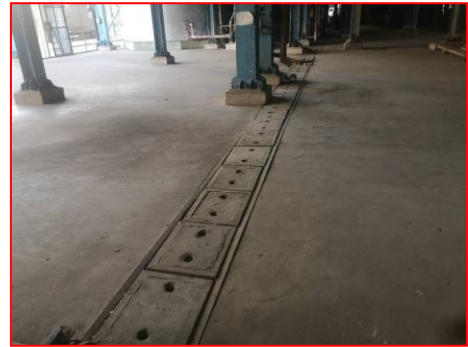
ภาพที่ 2.2-20 รางระบายน้ำ ในพื้นที่โครงการ
