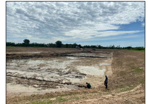
การขุดลอกตะกอนจากระบบบำบัดน้ำเสีย บ่อ D2
