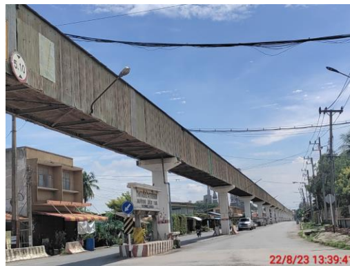
รูปที่ 5 สายพานลำเลียงที่ผ่านชุมชนมีฝาทรงปิดมิดชิด
