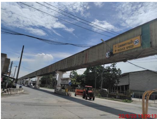
รูปที่ 5 สายพานลำเลียงที่ผ่านชุมชนมีฝาทรงปิดมิดชิด
