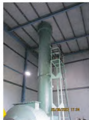
Wet Scrubber ของหน่วยชุบเคลือบลูกรีด เพื่อการซ่อมบำรุง (Chromium Plating)
