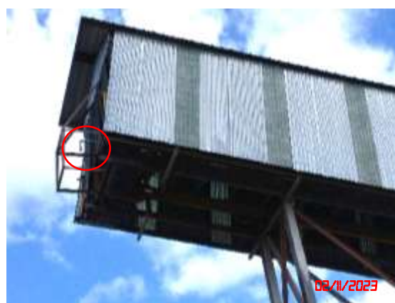
ระบบแปรย่น้ำบริเวณแหล่งกำเนิดฝุ่นละออง
