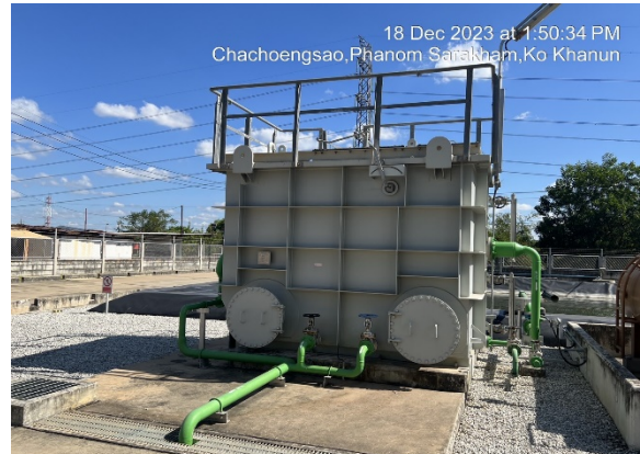
รูปที่ 2-5.4 ระบบ Oil Separator
