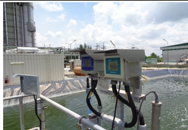
รูปที่ 2-5.2 (2) อุปกรณ์ตรวจวัดน้ำแบบ Online monitoring
