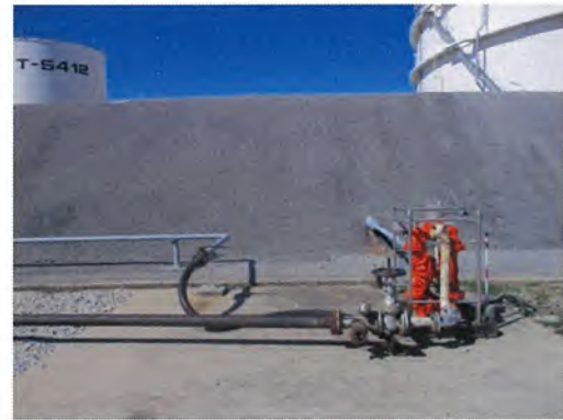
รูปที่ 3-52 วาล์วนิรภัยบริเวณท่อลำเลียง คอนเดนเสทและรีฟอร์เมต
