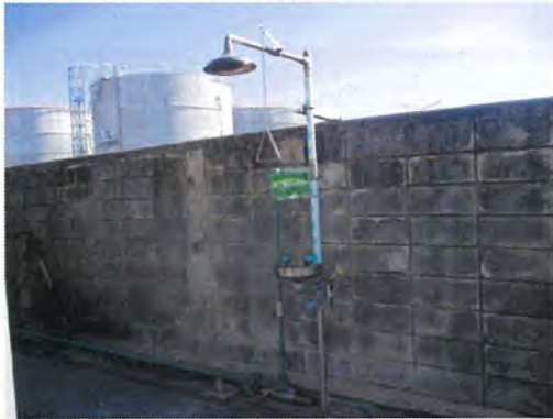
รูปที่ 3-29 อุปกรณ์ดับเพลิง และ Safety Shower & Eye Washer ในพื้นที่รวบรวมกากของเสีย
