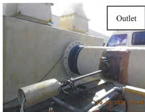
Inlet และ Outlet ของปล่อง Sulfur Scrubber
