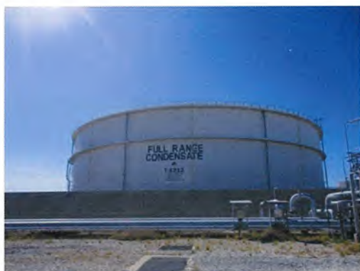
รูปที่ 3-3 ถังเก็บกากคอนเดนเสท (ถัง T-5212 และถัง T-5213)
