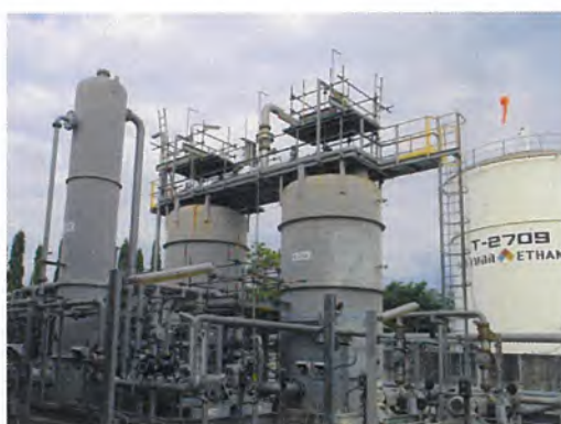
รูปที่ 3-8 Vapor Recovery Unit (VRU)
