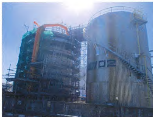
รูปที่ 3-7 Activated Carbon Canister
