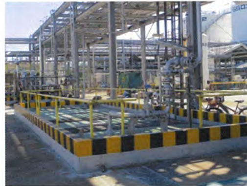
รูปที่ 3-18 บ่อพักสำหรับรองรับน้ำปนเปื้อนน้ำมัน (T-5418)
