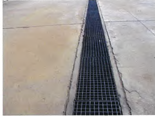
รูปที่ 3-30 รางระบายน้ำในพื้นที่รวบรวม กากของเสีย
