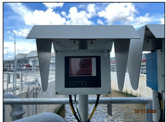
เครื่องมือวัดความนำไฟฟ้า (Conductivity)
