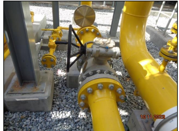
รูปที่ 2-32 อุปกรณ์วาล์วตัดแยกระบบ (Manual Isolation Valve)
