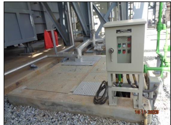
รูปที่ 2-6 บ่อแยกน้ำ-น้ำมัน (Oil Water Separator)
