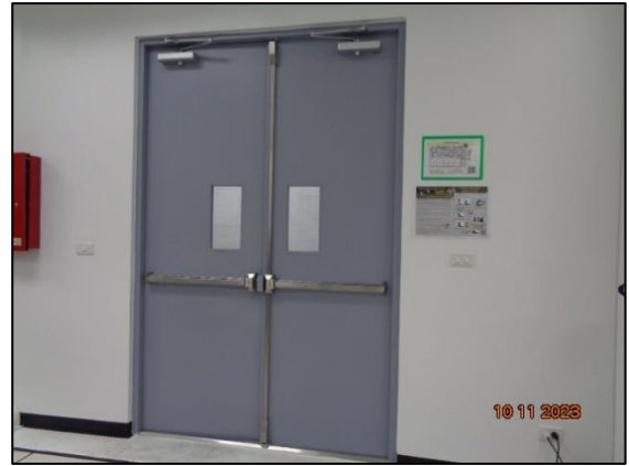
รูปที่ 2-14 ประตูและผนังที่ป้องกันเสียงสำหรับห้องควบคุม
