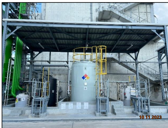
รูปที่ 2-30 พื้นที่จัดเก็บวัตถุดิบและสารเคมี และป้ายระบุชนิดของสารเคมี
