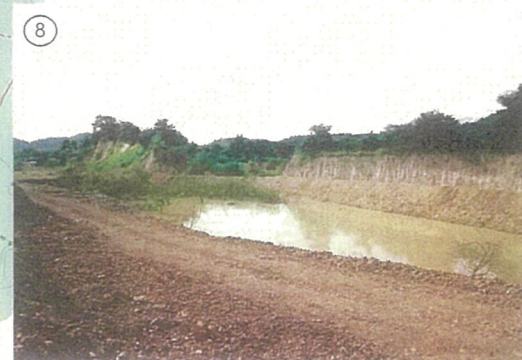
ทำคันดินปิดกั้นขุมเหมืองเก่า ใช้เป็นบ่อตกตะกอน
