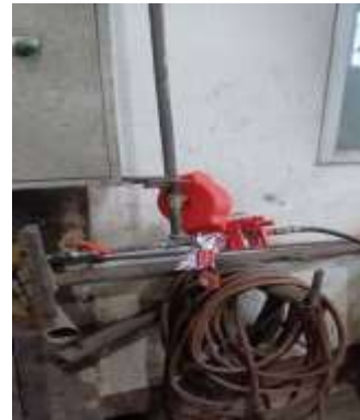
รูปที่ 98 การล็อกคกุญแจ-แขวนป้าย (Lock Out-Tag Out)
