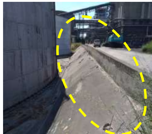
รูปที่ 107 คันคอนกรีตล้อมรอบบริเวณถังเก็บกากน้ำตาล
