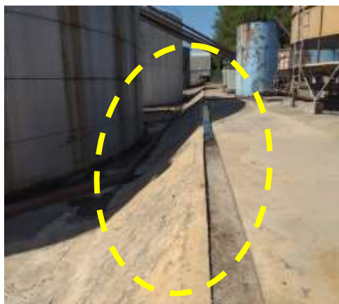
รูปที่ 107 คันคอนกรีตล้อมรอบบริเวณถังเก็บกากน้ำตาล
