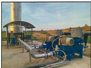
ระบบหอหมุนเวียนส่วนเกินแบบปิด (Enclosed Flare)
