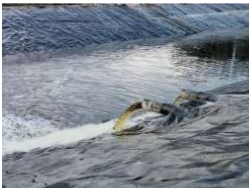
รูปที่ 41 ระบบบำบัดน้ำเสียแบบชีวภาพ (มีการปู HDPE)
