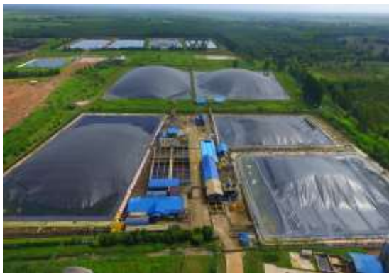
รูปที่ 28 บ่อกากสาบปิดคลุมด้วย HDPE และตาข่าย
