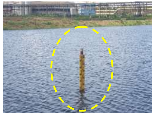
รูปที่ 58 เสาแสดงระดับน้ำในบ่อน้ำดิบและบ่อน้ำ
