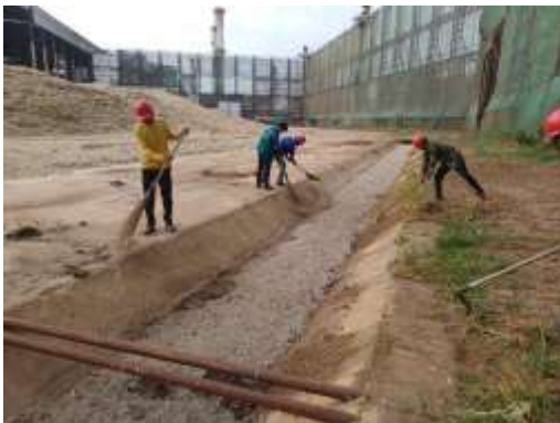
รูปที่ 20 เจ้าหน้าที่ทำความสะอาด/การขุดลอกรางระบายน้ำรอบลานกองเก็บกากอ้อย
