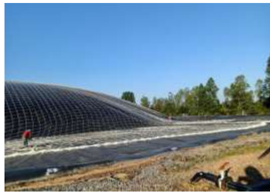
รูปที่ 28 บ่อกากสาบปิดคลุมด้วย HDPE และตาข่าย
