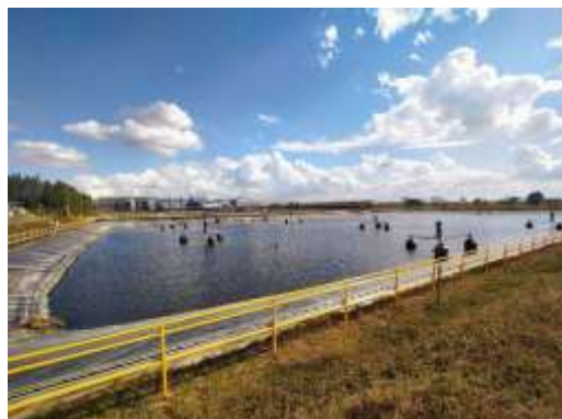
รูปที่ 41 ระบบบำบัดน้ำเสียแบบชีวภาพ (มีการปู HDPE)
