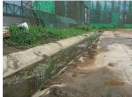
รูปที่ 17 รางระบายน้ำโดยรอบลานกองเก็บกากอ้อย
