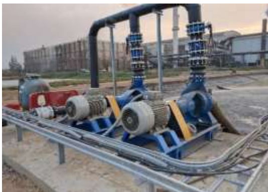
รูปที่ 29 ระบบไฟฟ้าและปั๊มไฟฟ้า รอบบ่อเก็บกากสา
