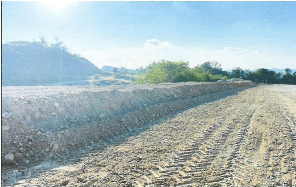
รูปที่ 4 แสดงคันทำนบดินอัดแน่นกั้นกิจกรรมภายในเขตพื้นที่โครงการฯ
