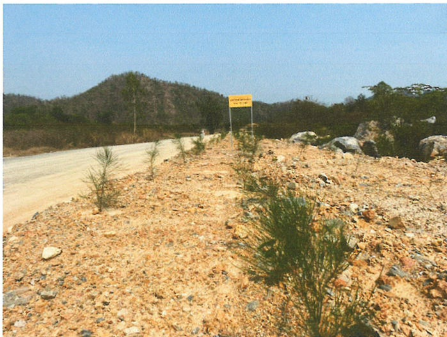
รูปที่ 13 แสดงคันทำนบกินพร้อมทั้งการปลูกพืชเป็นฉากกั้นกิจกรรมภายในเขตพื้นที่โครงการฯ
