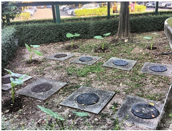
รูปที่ 3-20 ถังกรองไร้อากาศ สำหรับบำบัดน้ำเสีย จากกิจกรรมของพนักงาน
