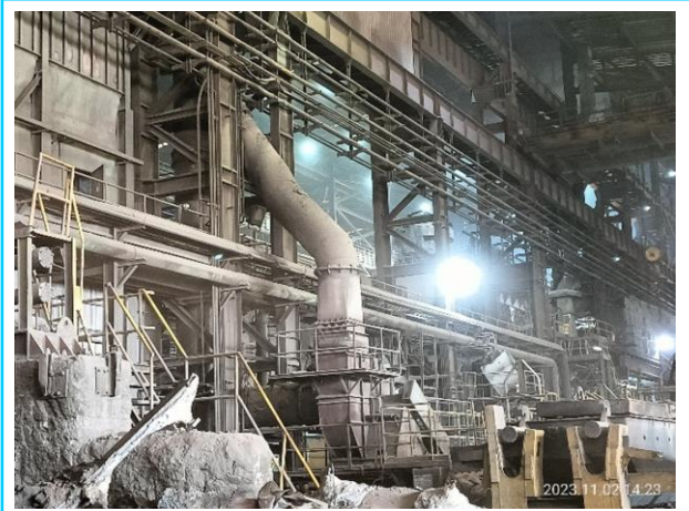
รูปที่ 3-4 ท่อรวบรวมระบบกำจัด Secondary Fume ที่เตา EAF และระบบ Booster Fan ที่เตา LF
