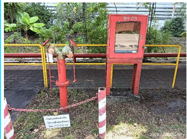
รูปที่ 3-43 ติดตั้งอุปกรณ์ดับเพลิงโดยรอบพื้นที่โครงการ
