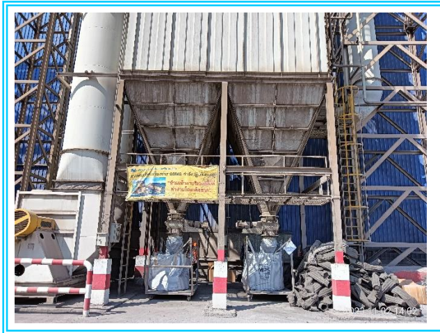
รูปที่ 3-11 ระบบ Dust Collector ของอาคารเท Slag และถุงเก็บรวบรวมฝุ่นรอส่งไปกำจัด
