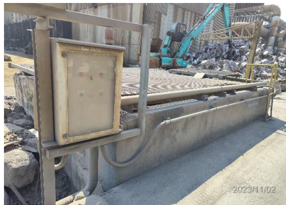
รูปที่ 3-17 สร้างรางระบายน้ำ และกันขอบ รอบพื้นที่คอนกรีต และป่อสำหรับเก็บรวบรวมน้ำจากการฉีดพรมเหล็ก เพื่อหมุนเวียนกลับมาใช้ใหม่
