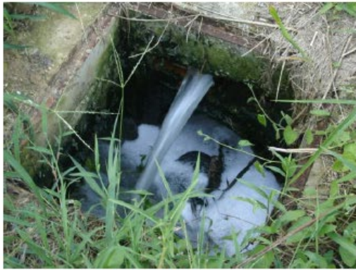
ข. บ่อพัก (Manhole) รับน้ำทิ้งจากการบำบัด
