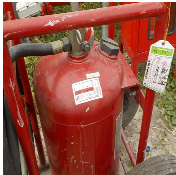
รูปที่ 3-10 การตรวจเช็คอุปกรณ์ดับเพลิงแบบติดล้อ บริเวณหน้าท่าเทียบเรือ
