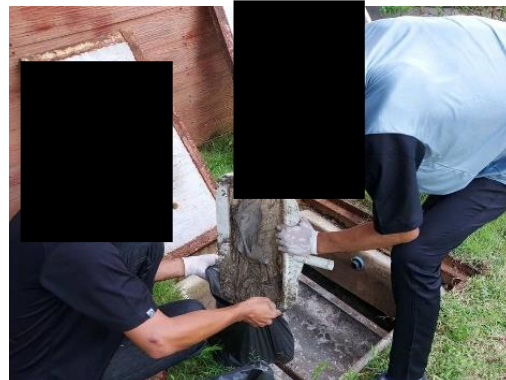
การตัดไขมันระบบบำบัดน้ำเสีย
