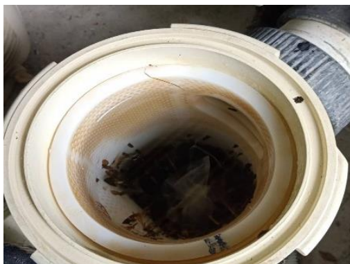
การทำความสะอาดเครื่องกรองสระว่ายน้ำ
