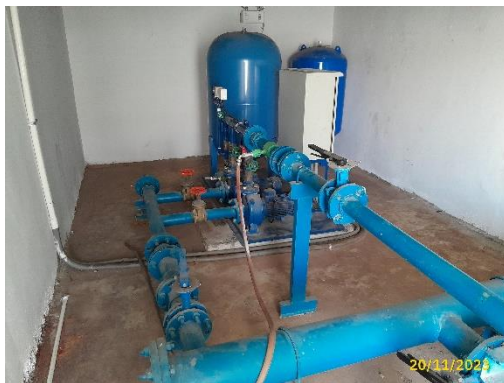
ปัมน้ำเสริมแรงดันอาคาร D
