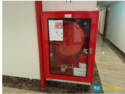
ตู้สายฉีดน้ำดับเพลิง
