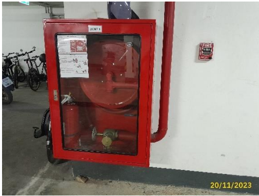
ตู้สายฉีดน้ำดับเพลิง
