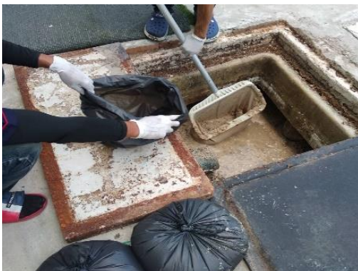
การตัดไขมันระบบบำบัดน้ำเสีย
