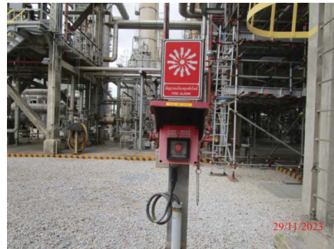
รูปที่ 3.1-1 (รูปที่ 65 Manual Call Point)
