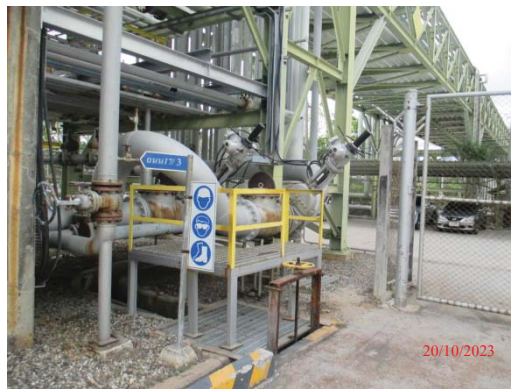
รูปที่ 3.1-1 (รูปที่ 93 วาล์วตัดแยกระบบ)
