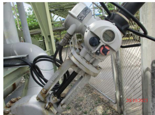
รูปที่ 3.1-1 (รูปที่ 90 On-Off Valve)
