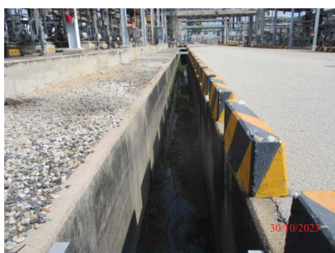
รูปที่ 3.1-1 (รูปที่ 32 Clean Water Sewer (CWS) บริเวณพื้นที่ลานถังเก็บกัก)
