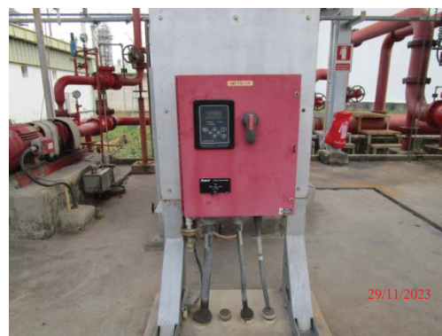
รูปที่ 3.1-1 (รูปที่ 79 Jockey Pump)
