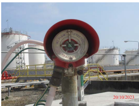
รูปที่ 3.1-1 (รูปที่ 66 Flame Detector)
