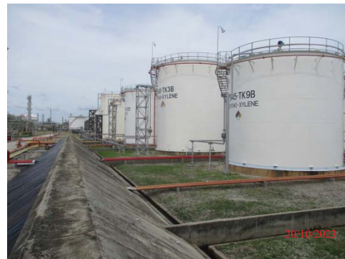
รูปที่ 3.1-1 (รูปที่ 61 ถังกักเก็บสัอมรอบถังเก็บสารอง)
