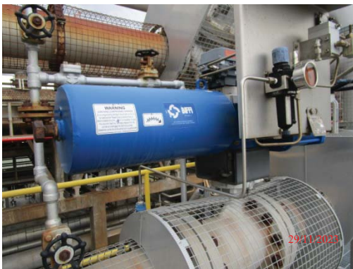
รูปที่ 3.1-1 (รูปที่ 89 Remote Shut-off Valve)
