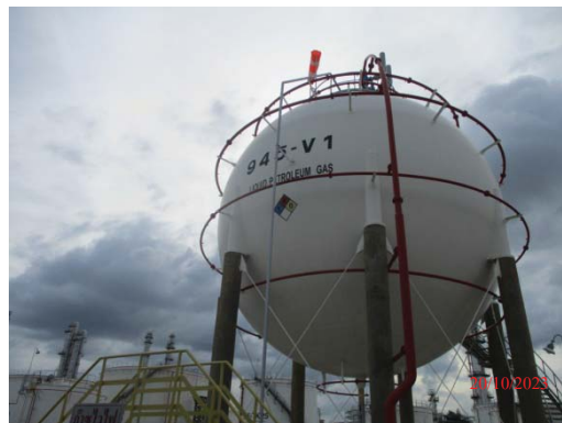
รูปที่ 3.1-1 (รูปที่ 84 ระบบฉีดพรมน้ำ บริเวณถังเก็บสำรอง)
