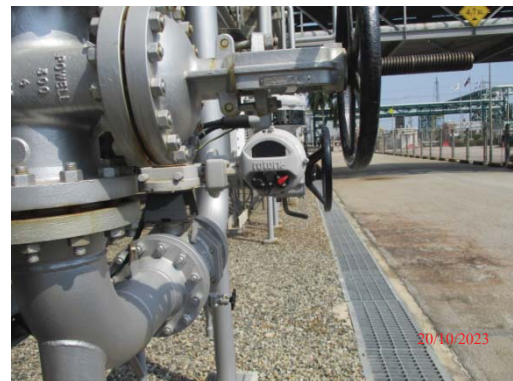
รูปที่ 3.1-1 (รูปที่ 89 Remote Shut-off Valve)
