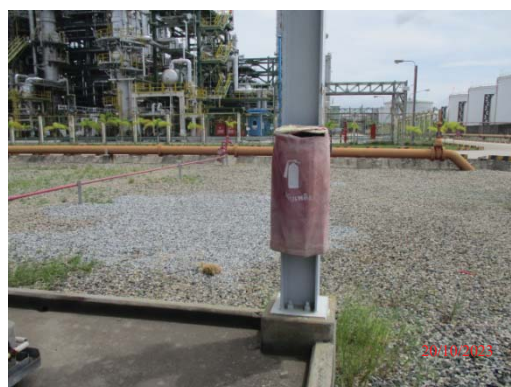
รูปที่ 3.1-1 (รูปที่ 76 เครื่องดับเพลิงชนิดผงเคมีแห้ง)
