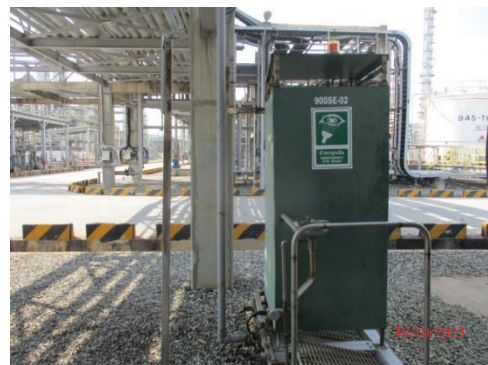
รูปที่ 3.1-1 (รูปที่ 50 อุปกรณ์ชำระล้างฉุกเฉิน)
