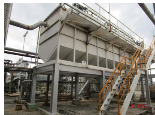
รูปที่ 3.1-1 (รูปที่ 21 Dissolved Air Flotation (DAF))
