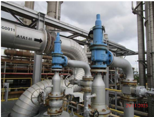
รูปที่ 3.1-1 (รูปที่ 88 Safety Valve บนท่อขนส่ง)
