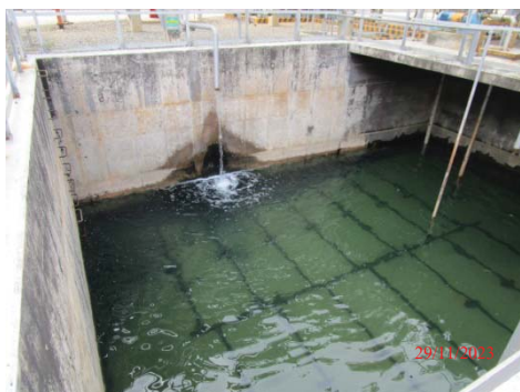
รูปที่ 3.1-1 (รูปที่ 28 บ่อ 940-XC1 ขนาด 280 ลบ.ม.)
