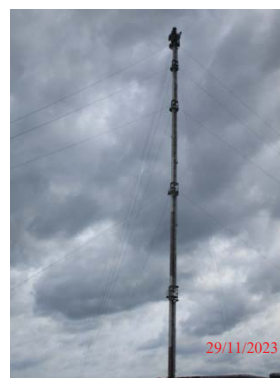
รูปที่ 3.1-1 (รูปที่ 3) Flare
