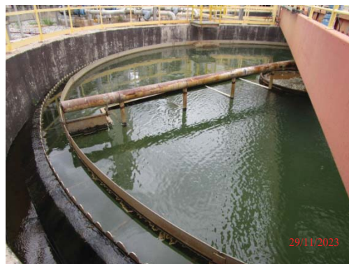
รูปที่ 3.1-1 (รูปที่ 23 Clarifiers)
