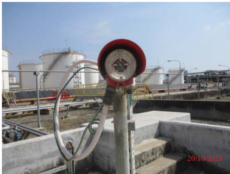
รูปที่ 3.1-1 (รูปที่ 64 Gas Detector บริเวณถังเก็บสำรอง)
