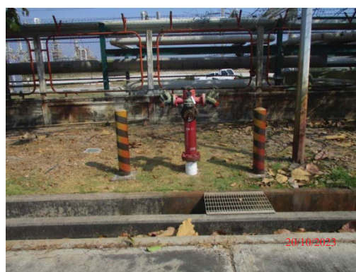
รูปที่ 3.1-1 (รูปที่ 75 Water Hydrant)
