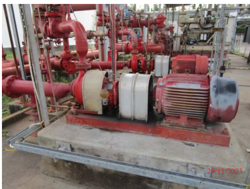
รูปที่ 3.1-1 (รูปที่ 83 ปั๊มน้ำดับเพลิง แบบไฟฟ้า)
