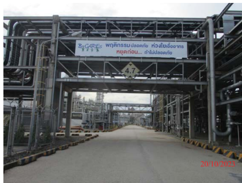
รูปที่ 3.1-1 (รูปที่ 85 ท่อรับส่งวัตถุดิบ-ผลิตภัณฑ์วางตัวบน Pipe Rack และ Pipe Bride)
