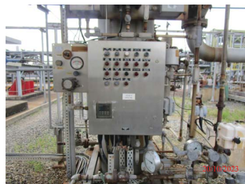
รูปที่ 3.1-1 (รูปที่ 63 หน้าจอควบคุมระบบการเผาไหม้สารไฮโดรคาร์บอน)
