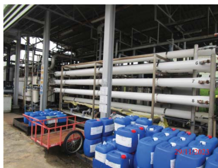
รูปที่ 3.1-1 (รูปที่ 27 ระบบ UF&RO)
