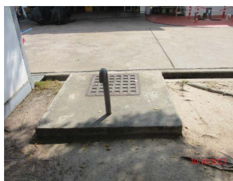
รูปที่ 3.1-1 (รูปที่ 31 Sanitary Sewer (SS) บริเวณพื้นที่ลานถังเก็บกัก)
