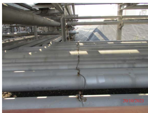
รูปที่ 3.1-1 (รูปที่ 87 สายดินบริเวณท่อขนส่ง)
