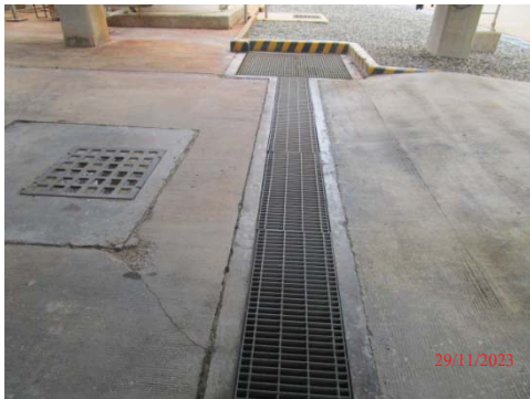
รูปที่ 3.1-1 (รูปที่ 10 Oily Water Sewer)
