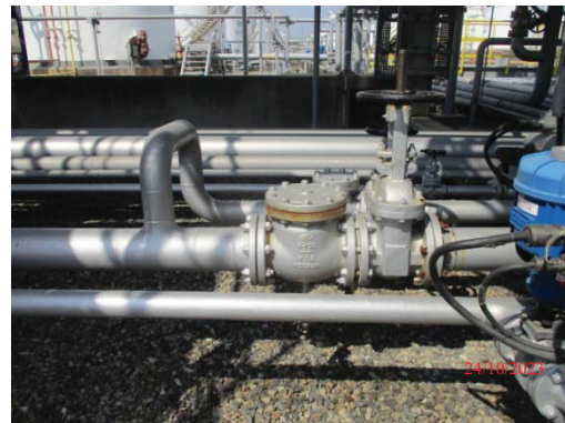
รูปที่ 3.1-1 (รูปที่ 92 Check Valve)
