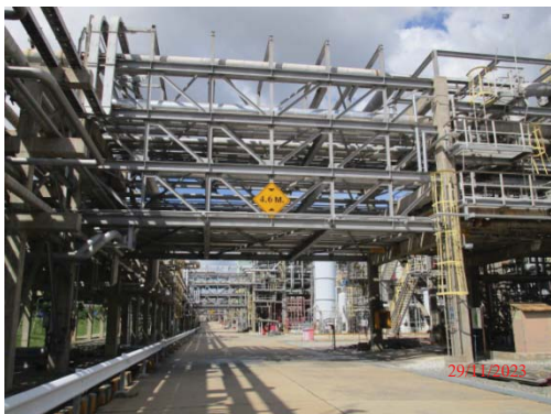
รูปที่ 3.1-1 (รูปที่ 85 ท่อรับส่งวัตถุดิบ-ผลิตภัณฑ์วางตัวบน Pipe Rack และ Pipe Bride)
