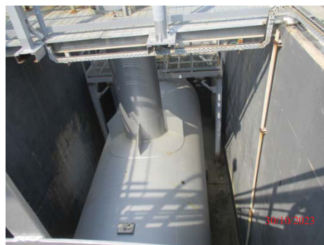
รูปที่ 3.1-1 (รูปที่ 29 Closed Aromatics Drain (CAD) บริเวณพื้นที่ลานถังเก็บกัก)
