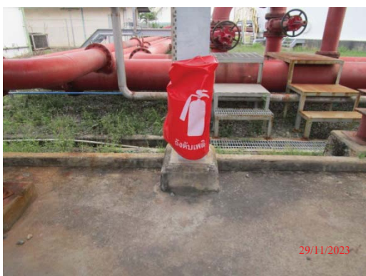
รูปที่ 3.1-1 (รูปที่ 76 เครื่องดับเพลิงชนิดผงเคมีแห้ง)
