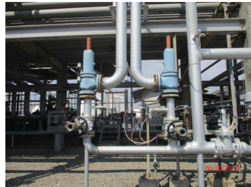
รูปที่ 3.1-1 (รูปที่ 88 Safety Valve บนท่อขนส่ง)
