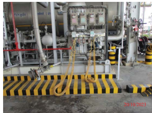
รูปที่ 3.1-1 (รูปที่ 70 Grounding บริเวณ Loading Rack)
