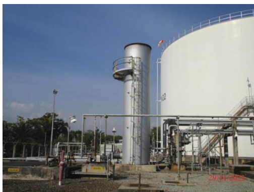
รูปที่ 3.1-1 (รูปที่ 6 ระบบกำจัดไอสาร ไอโธคาร์บอน (Vapor Disposal System) บริเวณลานถังเก็บกัก)
