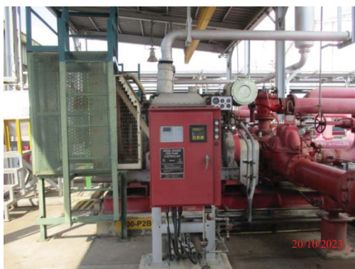
รูปที่ 3.1-1 (รูปที่ 78 ปั้มน้ำดับเพลิง แบบ Diesel Pump)
