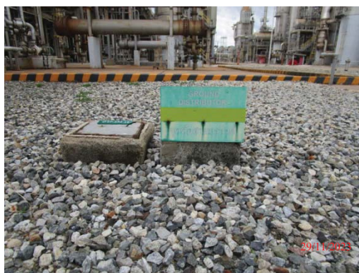
รูปที่ 3.1-1 (รูปที่ 86 Marking Post บริเวณแนวไต้ดิน)
