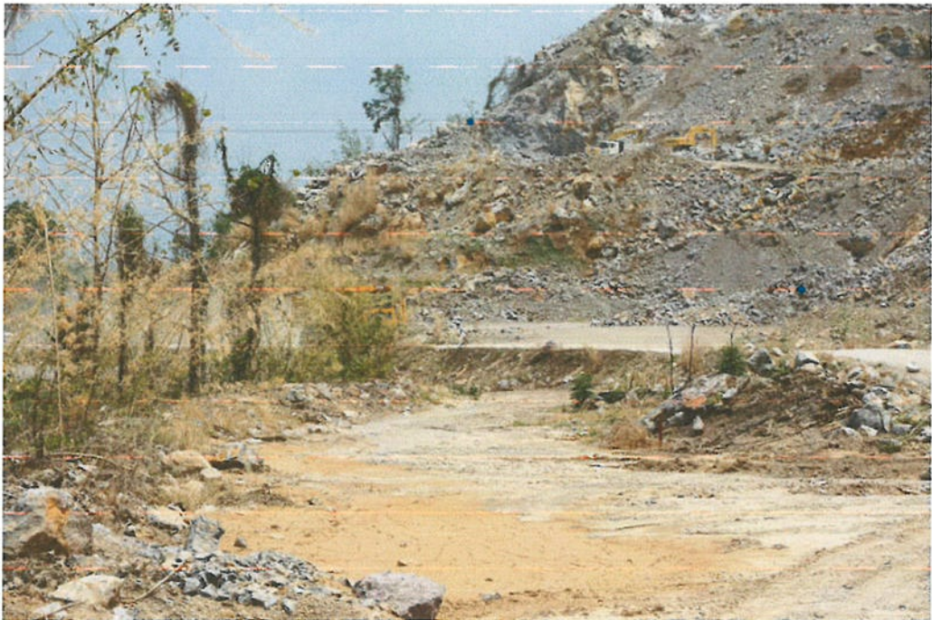
รูปที่ 8 แสดงคันทำนบดินและบ่อดักตะกอน บริเวณด้านทิศตะวันออกของพื้นที่โครงการประทามบัตรที่ 25573/16063 ภาพนี้ถ่ายจากบริเวณค่าพิกัด 710238.11 _E และ 1749768.60 _N มองไปทางด้านทิศใต้
