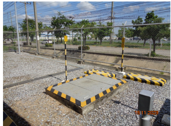
รูปที่ 3-6 อุปกรณ์ดับเพลิง และวาล์วควบคุม ประจําสถานีก๊าซ
