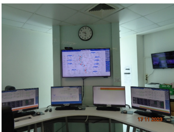
รูปที่ 3-13 ศูนย์ควบคุมฉุกเฉิน (SCADA ROOM)
