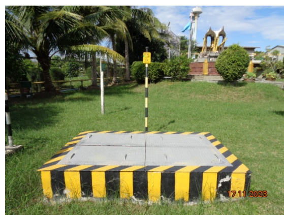
รูปที่ 3-2 ระบบวาล์วใต้ดินเพื่อสามารถตัดแยกระบบกรณีเกิดเหตุฉุกเฉิน
