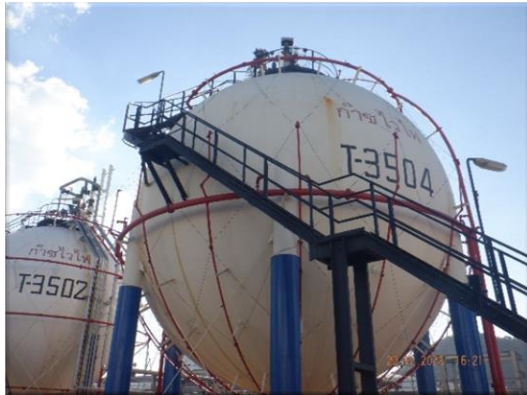
รูปที่ 2-27 ถังเก็บก๊าซปิโตรเลียมเหลว
