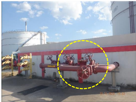
รูปที่ 2-29 วาล์วปิดทางออกฉุกเฉินสำหรับถังเก็บก๊าซปิโตรเลียมเหลว
