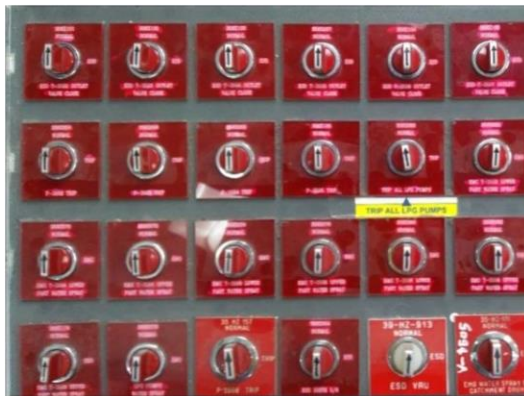
รูปที่ 2-33 ระบบหยุดสูบน้ำฉุกเฉินทั้งระบบ บริเวณห้องควบคุม
