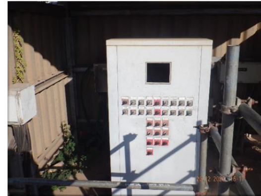
รูปที่ 2-32 ระบบหยุดสูบน้ำฉุกเฉินทั้งระบบ บริเวณถังจัดเก็บ
