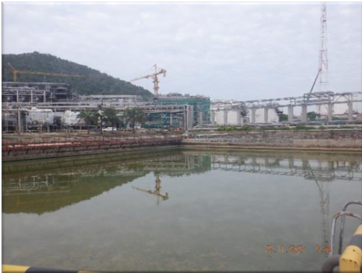
รูปที่ 2-5 หน่วยบำบัดน้ำก่อนระบายออกนอกโรงงาน
