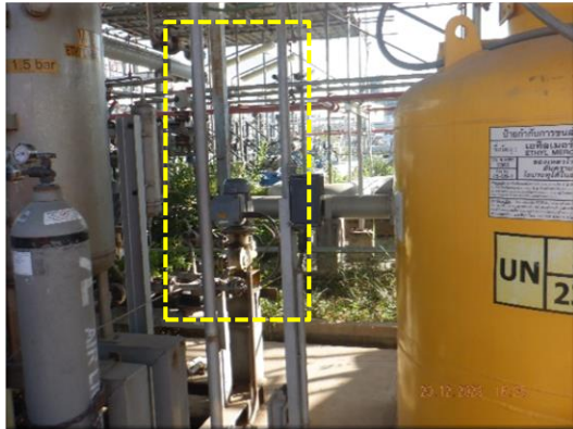
รูปที่ 2-35 Lock-out Mercaptan Injection Pump
