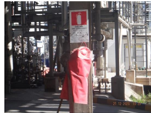
รูปที่ 2-42 อุปกรณ์ดับเพลิงชนิดมือถือชนิดผงเคมีแห้ง
