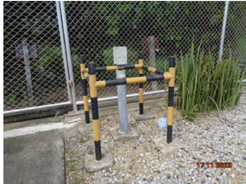
รูปที่ 3-8 ระบบวาล์วใต้ดินเพื่อสามารถตัดแยกระบบกรณีเกิดเหตุฉุกเฉิน
