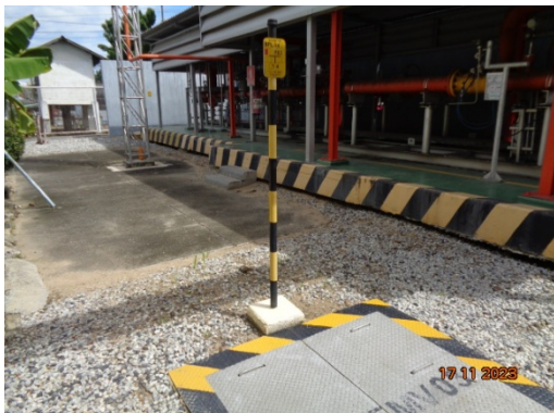
รูปที่ 3-8 ระบบวาล์วใต้ดินเพื่อสามารถตัดแยกระบบกรณีเกิดเหตุฉุกเฉิน
