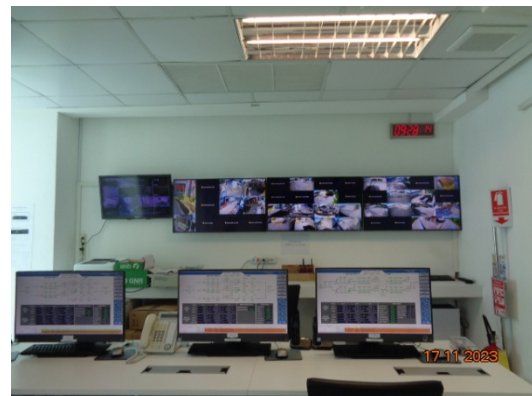
รูปที่ 3-7 ศูนย์ควบคุมฉุกเฉิน (SCADA ROOM)
