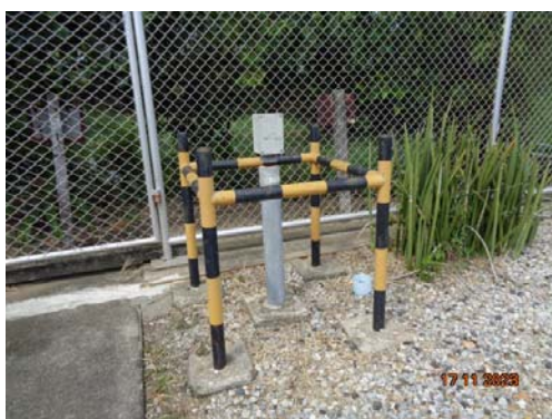
รูปที่ 3-3 ระบบวาล์วใต้ดินเพื่อสามารถตัดแยกระบบกรณีเกิดเหตุฉุกเฉิน
